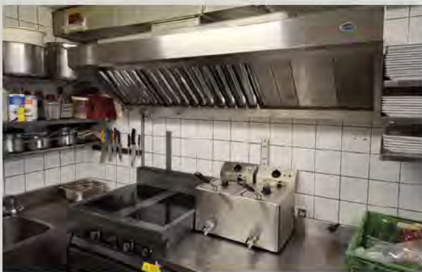
Bild 1: Hinter den Abscheidern beginnt der kritische Bereich.
